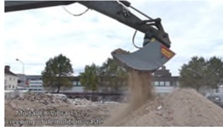
Criblage en démolitions.
