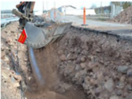
REPLISSAGE DE CANALISATION
